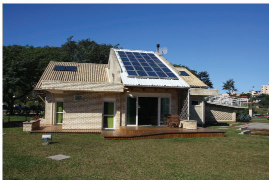
FIGURA 3 – Vista Nordeste da Casa.
