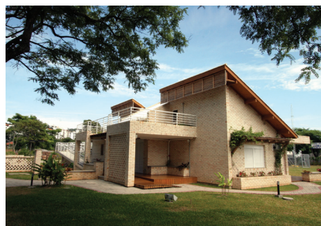
FIGURA 2 – Vista Sudeste da Casa.
